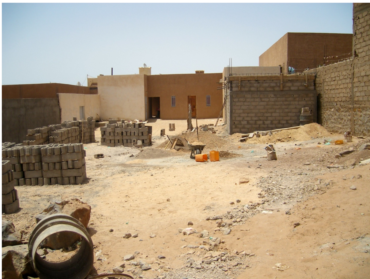
Le Centre Emel : au fond, la phase 1 en service, à l'avant plan, construction d'une classe supplémentaire (juin 2011)
